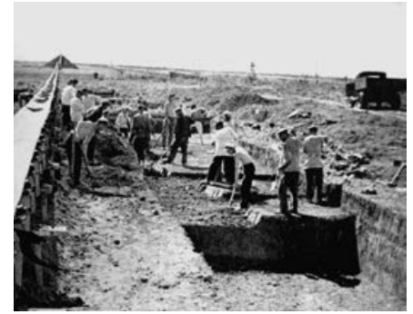
Erdarbeiten im Tscheljabinsker Besse- rungsarbeitslager, 1942
