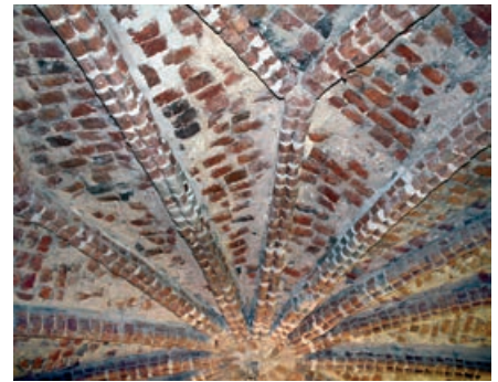
Erzbischöflicher Facettenpalast, Gewölberippen, 1433
