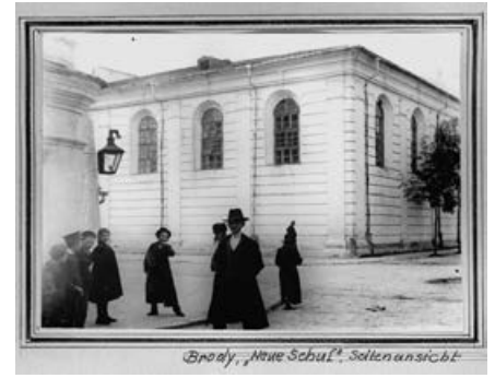
Brody, »Neue Schul«, Seitenansicht
