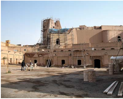
Das neue Museum, Lager und Werkstatt, Bauarbeiten im Jahre 2009
